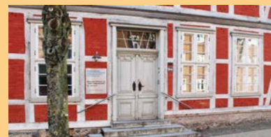
Altes Augustenstift Stiftstraße 9b 19053 Schwerin
